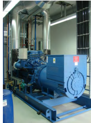
900 kVA mit externen Tischkühler am Dach BMW Dingolfing
