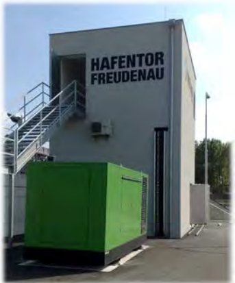
550 kVA Schallgedämmt 70dB(A) in 7m
