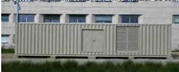
1000 kVA Schallgedämmt 68dB(A) in 7m 40 Fuß Container
