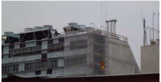
A121017 Star@ 22 Wien Stadlau Rechenzentrum 2 x 2300kW 180m Abgasleitung NW 500mm
